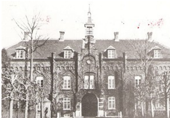
Afb. 62: Interneringskamp van Merksplas
