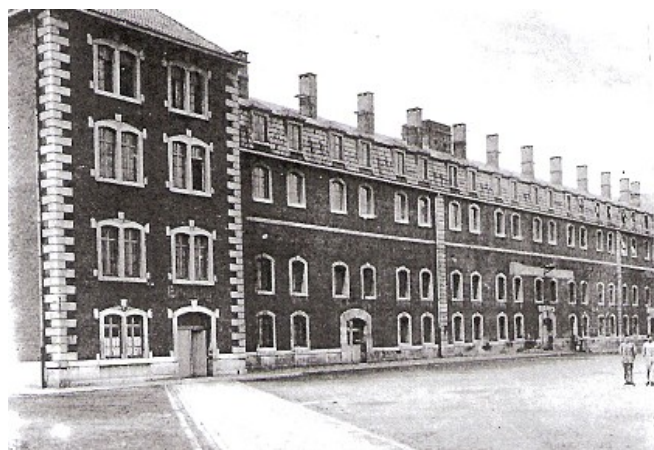
Afb. 84: Voorgevel van La Citadelle
